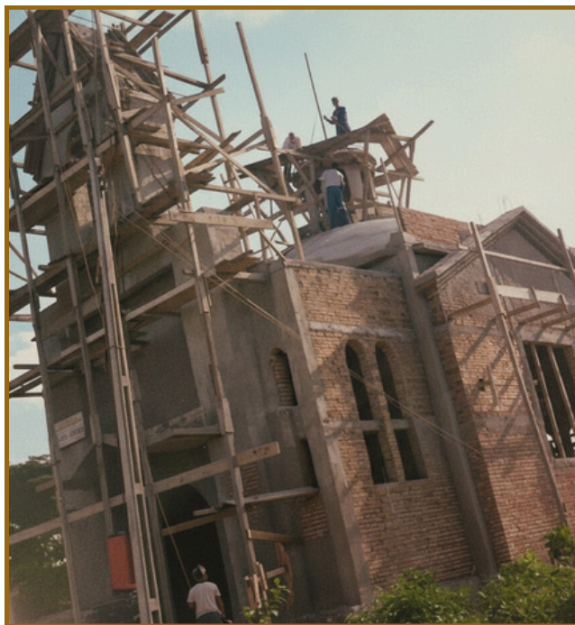
Construção da Paróquia Nossa Senhora da Proteção na Pedreira, São Paulo, 1972/1973.
