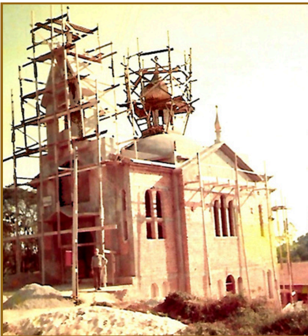
Construção da Paróquia Nossa Senhora da Proteção na Pedreira, São Paulo, 1974.
