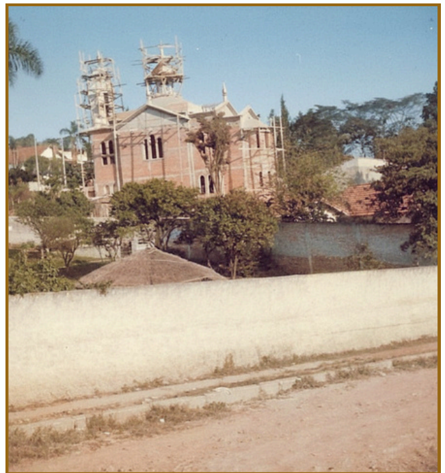
Construção da Paróquia Nossa Senhora da Proteção na Pedreira, São Paulo, 1974.
